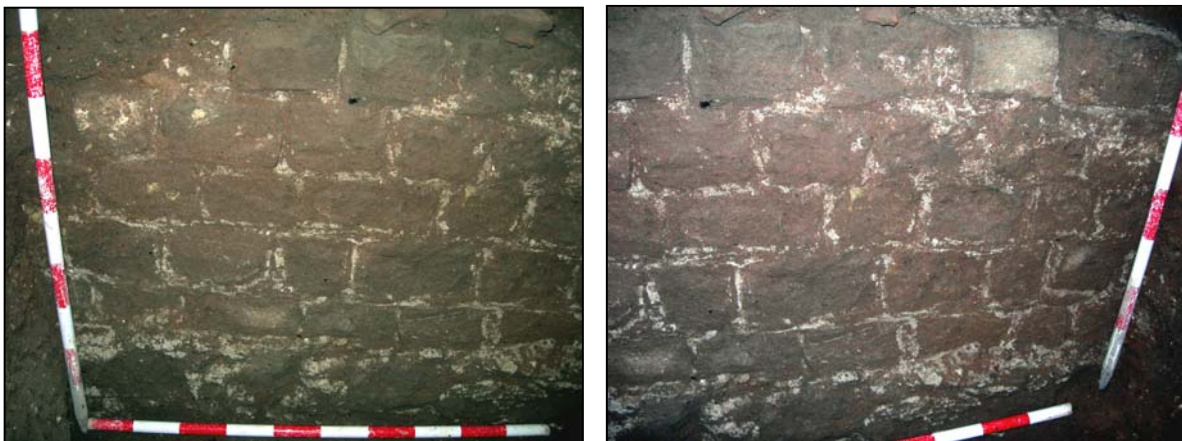
Vista de l'alçat del mur d' opus vittatum UE 119 , fet de petits carreus lligats amb morter de calç.
