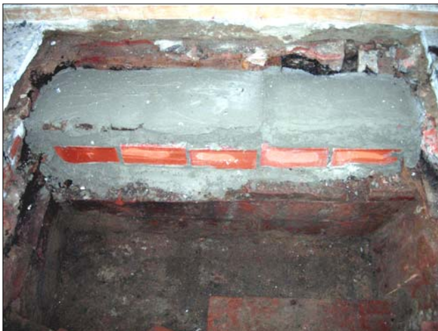
Vista de la claveguera ( UE 208 ) en finalitzar la seva reparació.
